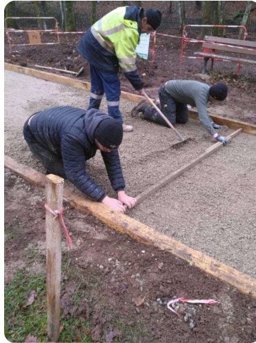
...Mise en place de la structure...
